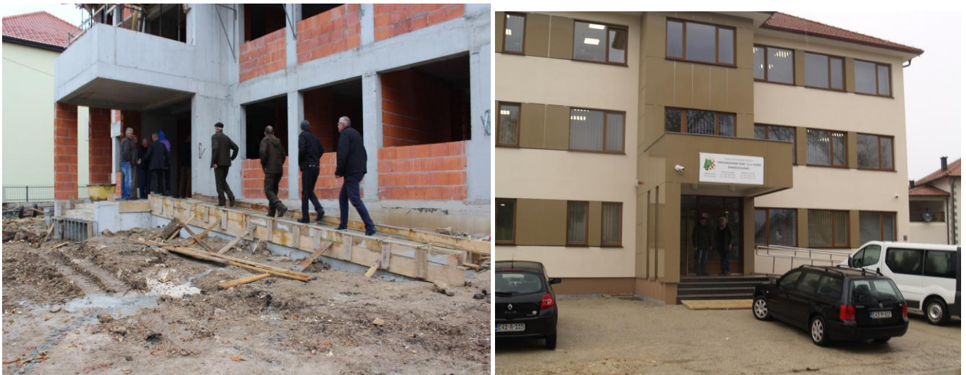
Fotografija 4. Zgrada šumarije Glamoč u tijeku izgradnje i nakon završetka radova
