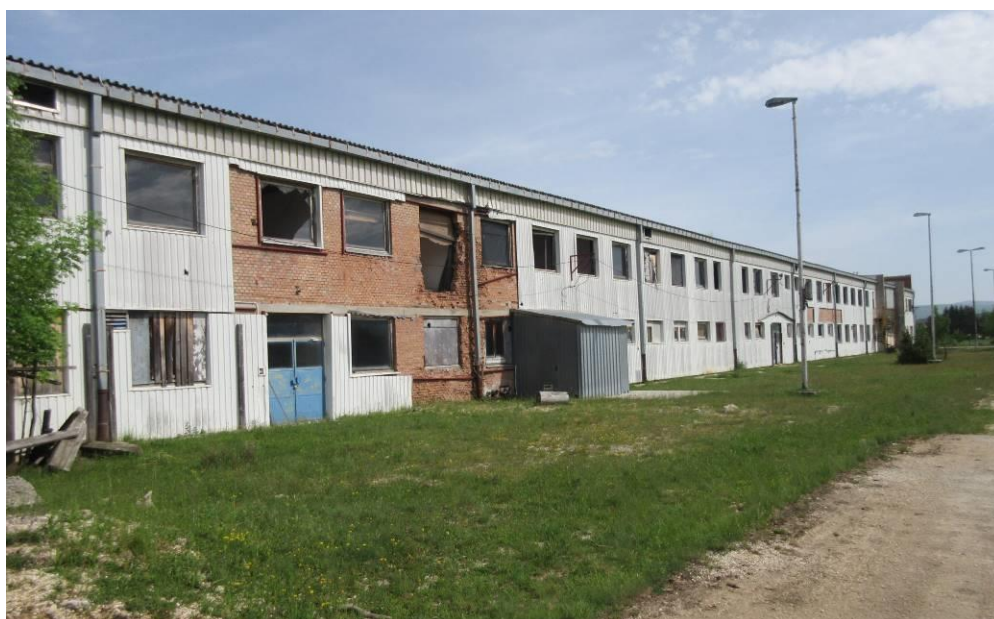
Slika 2. Pomoćne prostorije uz halu, istočna fasada objekta
